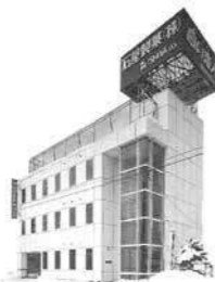
1979年に新築した本社工場
