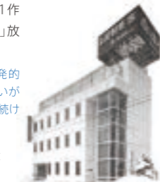
1979年に新築した本社工場
